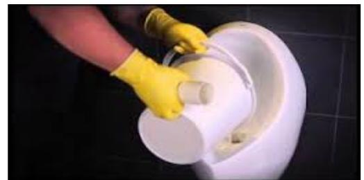
Der Einspareffekt kann neben den Wasser- und Abwasserkosten im Falle eines Neubaus auch die Zuleitungskosten umfassen. Hygienische Untersuchungen ergaben, dass wegen des fehlenden Wassers deutlich weniger Bakterien und Pilze in den wasserlosen Urinalen vorkommen. Der Siphon lässt sich in maximal 30 Sekunden wechseln und problemlos entsorgen.
